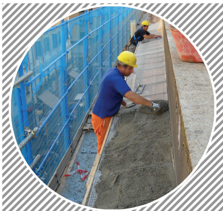
SCUOLA MEDIA CASSIODORO_Roma (RM) “Lavori di ristrutturazione”
