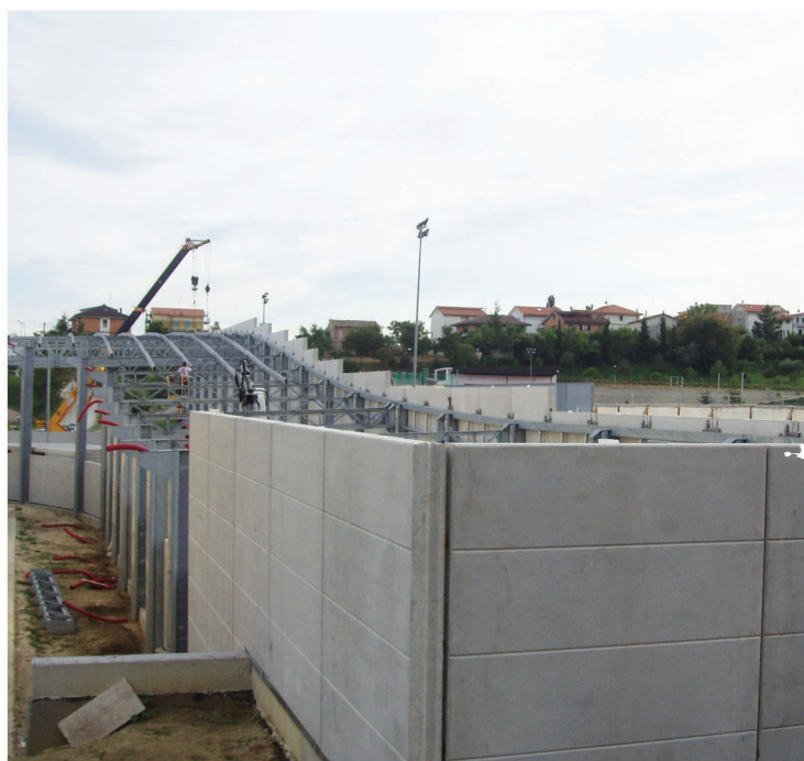
PISTA DI ATLETICA INDOOR_Fermo (FM) “Lavori di messa a norma e completamento”
