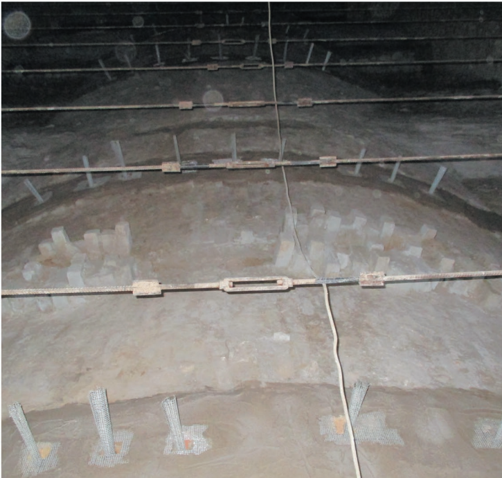
CHIESA DI SANT'ANTONIO_Catignano (PE) “Lavori di messa in sicurezza”
