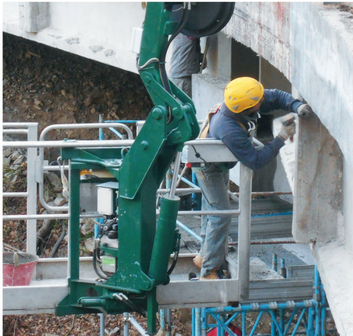
PONTE Intermesoli (TE) “Lavori di riparazione e ripristino della viabilità”
