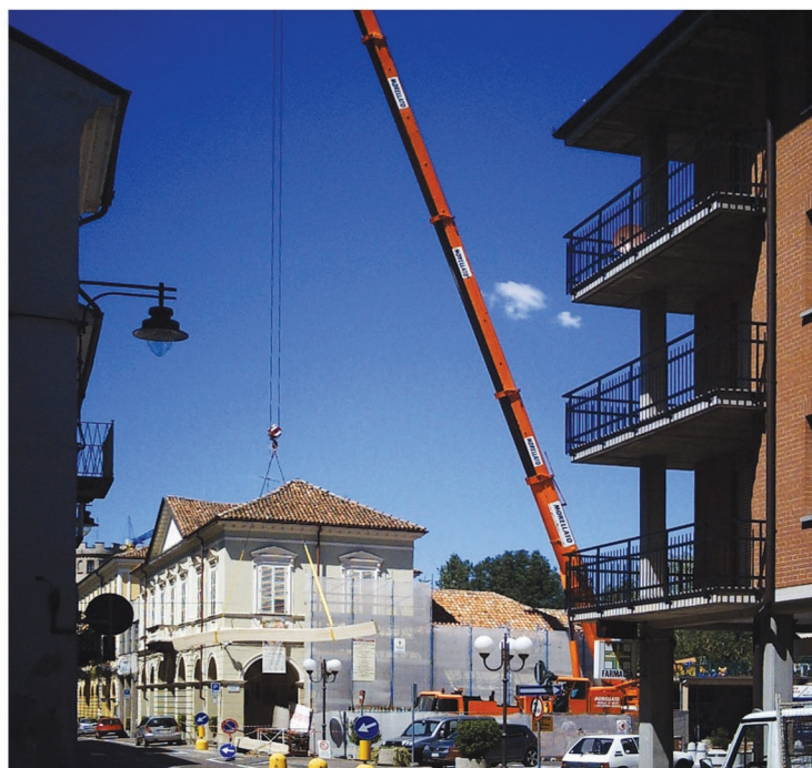
PALAZZO SERRATRICE_Costigliole D'Asti (AT) “Lavori di recupero”
