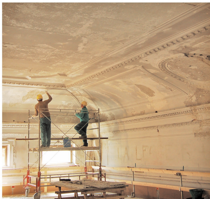
BIBLIOTECA_Busto Arsizio (VA) “Lavori per intervento di recupero funzionale”
