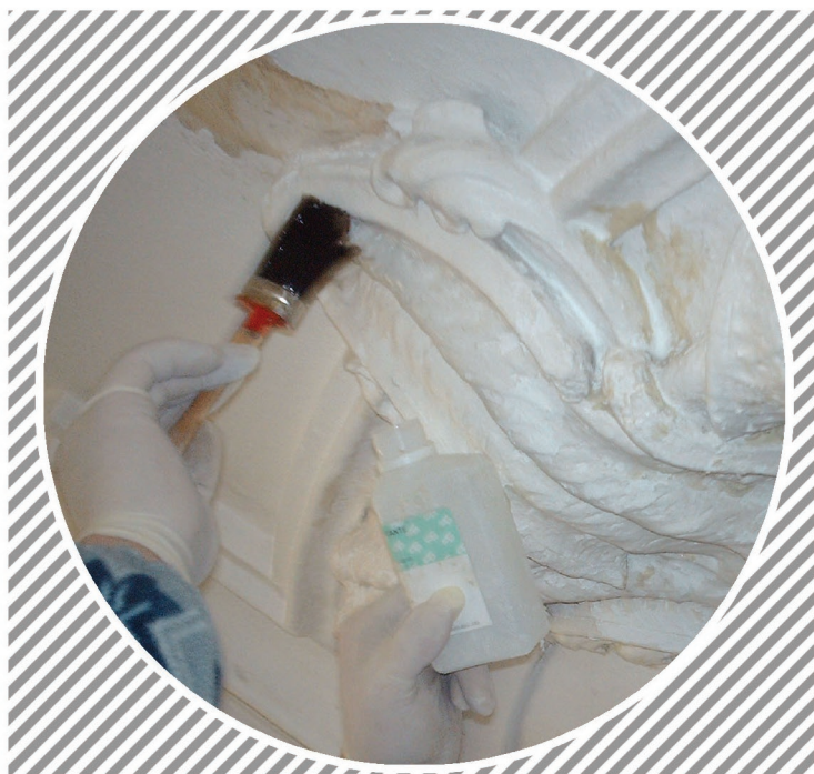
EX CHIESA DI SANT' ANTONIO_Rapino (CH) “Lavori di recupero strutturale e funzionale”
