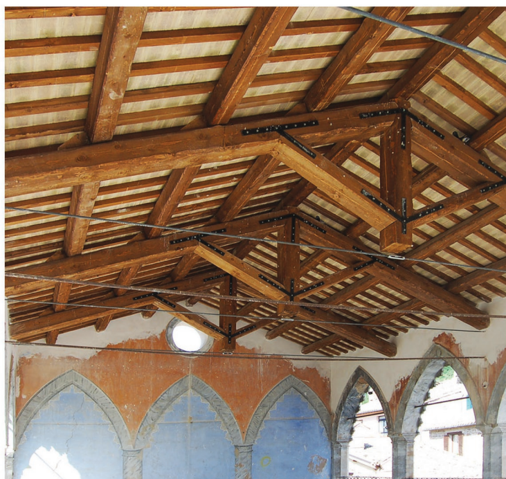
AGGREGATO_Muccia (MC) “Lavori di miglioramento sismico e restauro”
