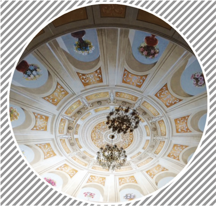
TEATRO PEDRINI_Brisighella (RA) “Lavori per ripristino e riduzione rischio sismico”
