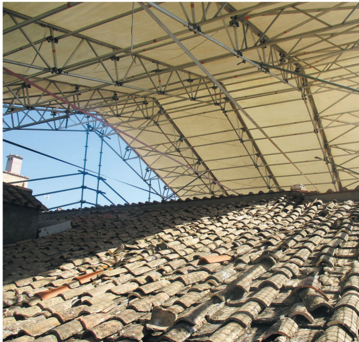
PALAZZO SPADA_ Roma (RM) “Lavori di rifacimento copertura lignea”
