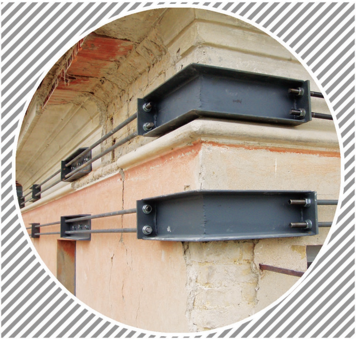
AGGREGATO_Faiano (TE) “Lavori di messa in sicurezza post sisma”
