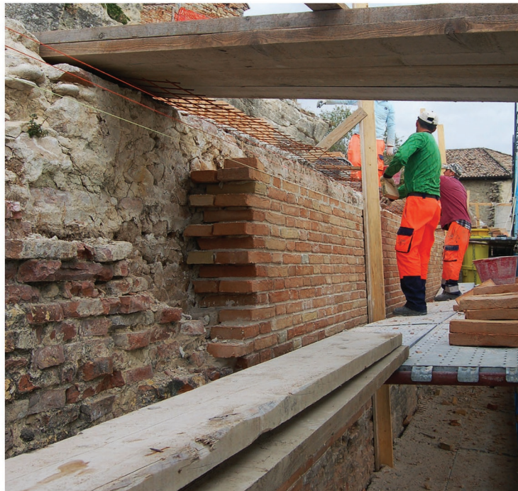
CANNONIERE ROCCA_Castrocaro Terme (FC) “Lavori di recupero”
